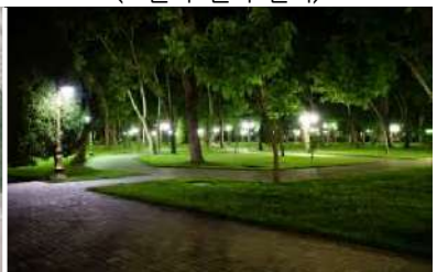
<가로등 설치로 야간시야 확보>
