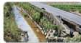
하천 제방 유실
