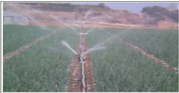
배수로, 스프링클러 설치
